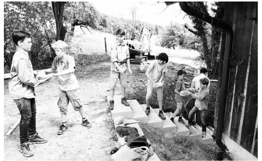
Die Pfadis arbeiten bei der Renovation der Buech kräftig mit.
